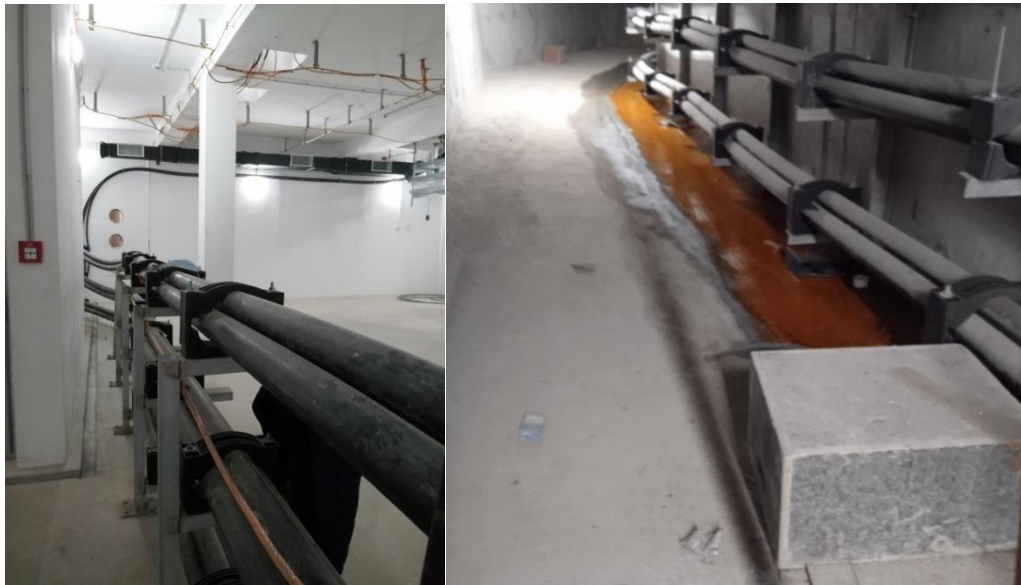
Slika 1. Levo kablovski prostor PRP Bor 5 i desno postojeći podzemni kablovski kanali
